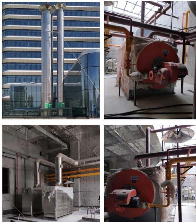
图 3-1 项目锅炉、低氮燃烧装置及排气筒照片
