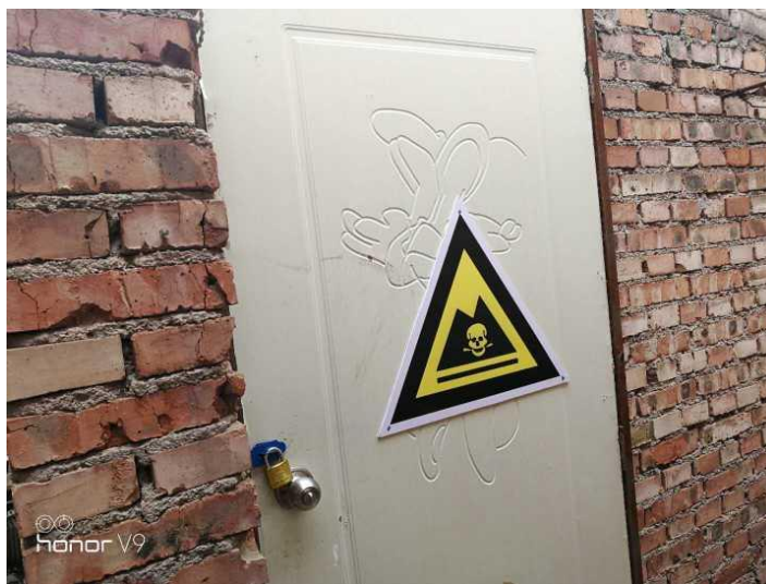
图 3 危废间实际照片
