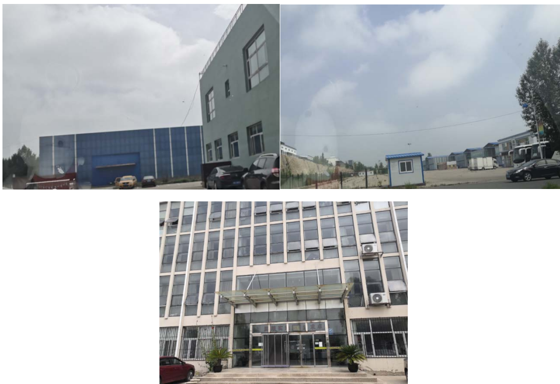
图 3-4 项目厂区现场照片
