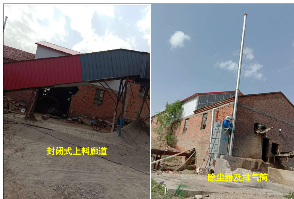
图 3-1 封闭廊道、布袋除尘器及排气筒实物图
