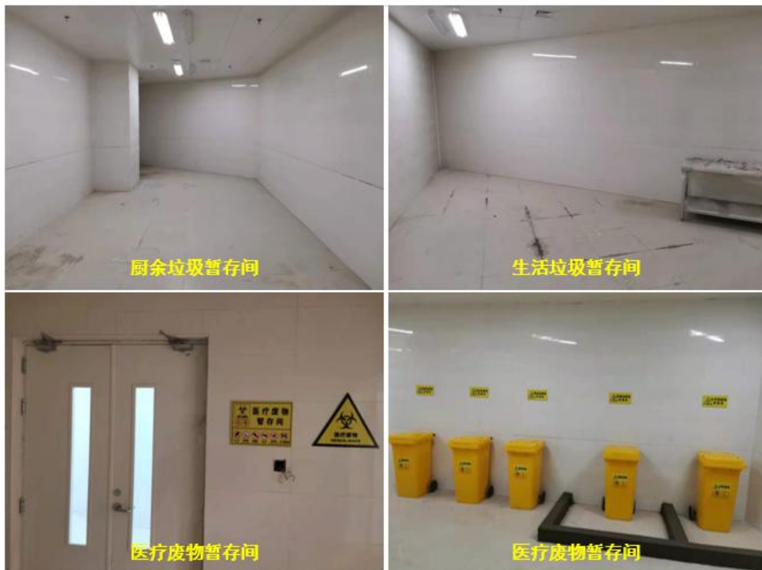
图 4-6 固废暂存间现场照片
