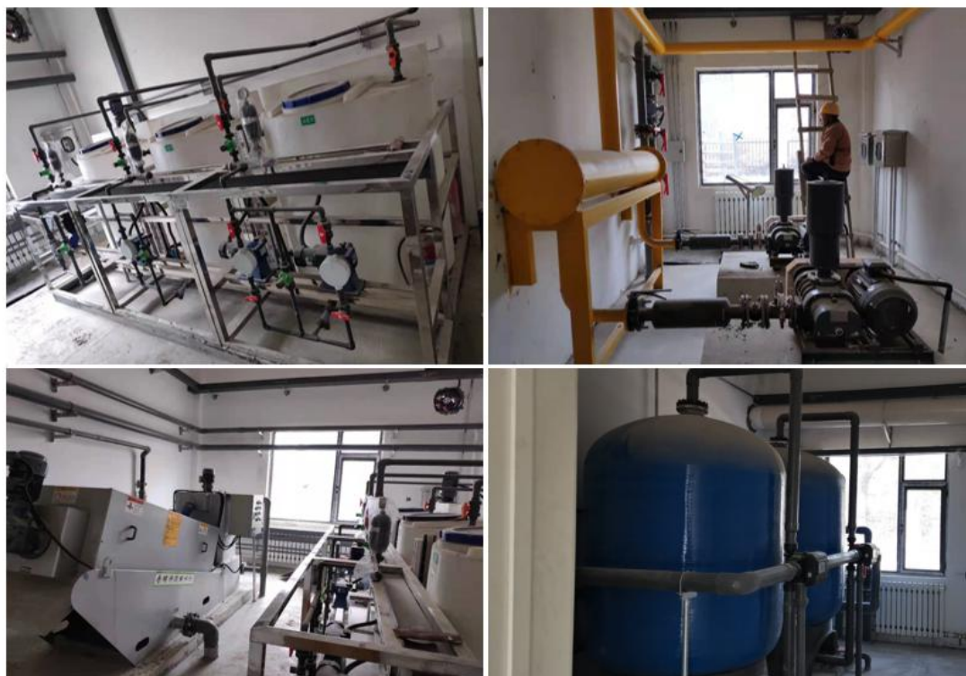
图 4-5 污水处理中心主要处理设施现场照片
