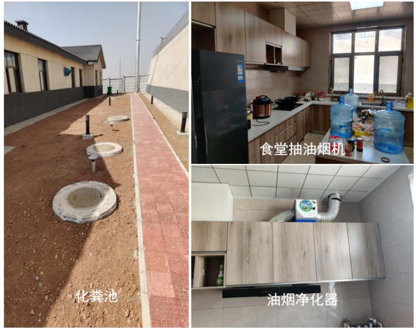
图 7-1 英图升压站化粪池及油烟净化器照片
